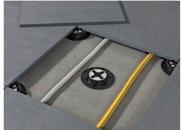
Stelzlager-Aufbau im Detail
