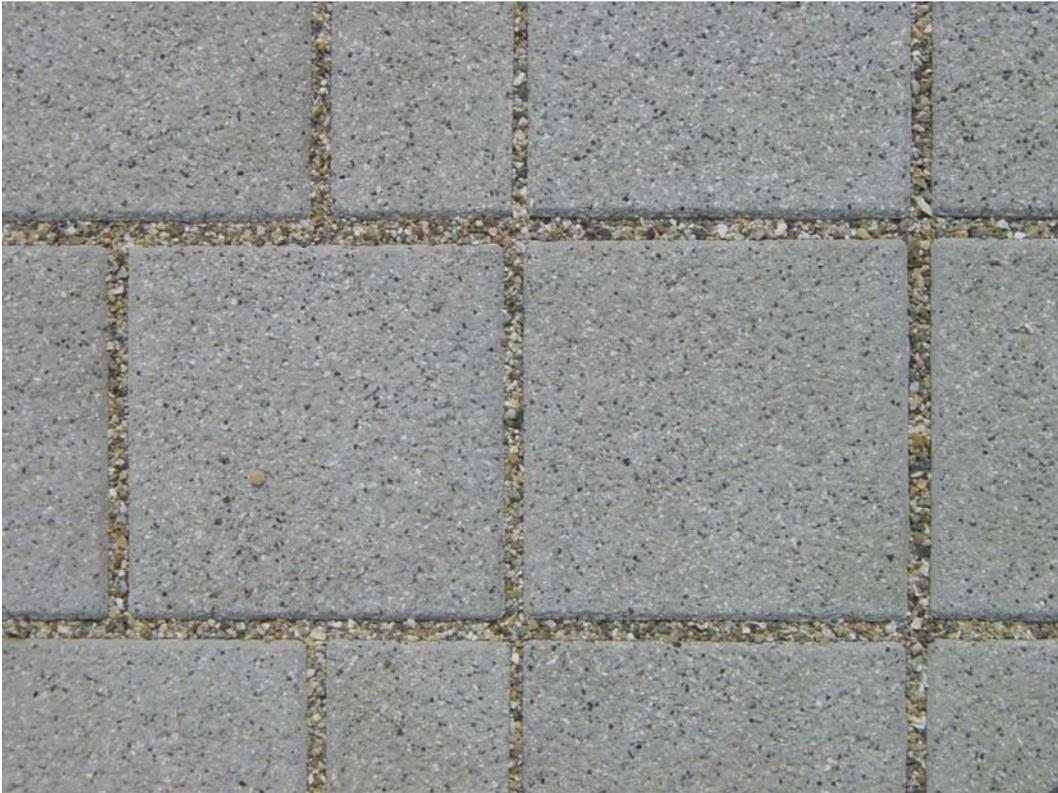
Bild 1: Pflastersystem Herbaturf Fuge 3 cm
