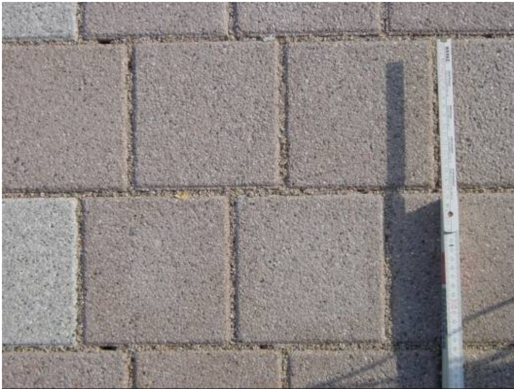
Bild 1: Pflastersystem Pasero Fuge 6,5 mm im Läuferverband
