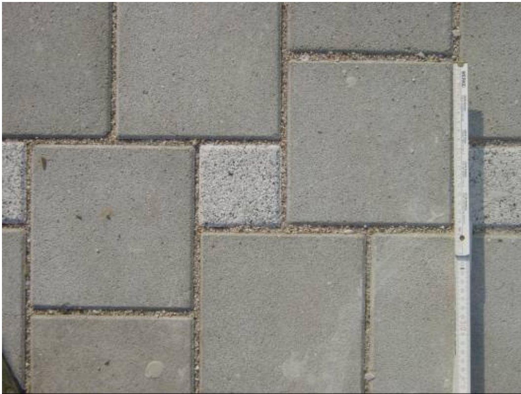
Bild 1: Pflastersystem Pasero Fuge 6,5 mm im Chemnitzer Verband
