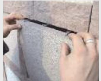
Sekundenschnelles Öffnen und Schließen der Verschlussplatte mit nicht sichtbarer Befestigungstechnik
