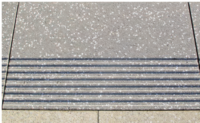
Profil der Standardfräsung 25 mm
