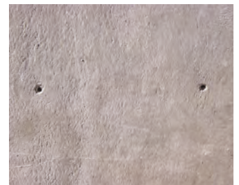
Ankerhülsen als Versetzhilfe
