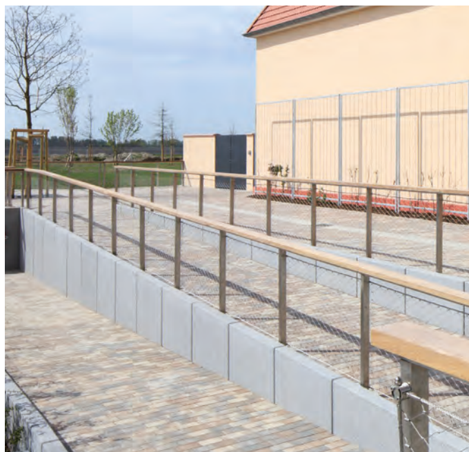
F-Roppenheim (67), „The Style Outlets“
